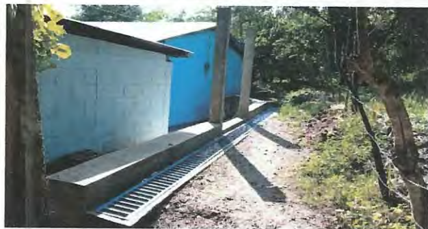
Foto 1: Mejoramiento de muro perimetral con 3 hiladas de block y maya al lado SUR de la escuela, 34.50m2
