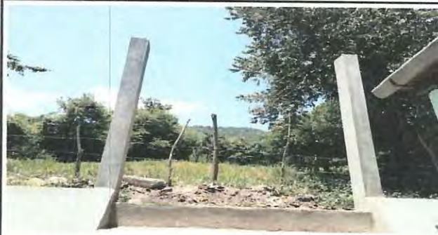
Foto 2: instalación de portón de acceso, con medidas 4,41 m2
